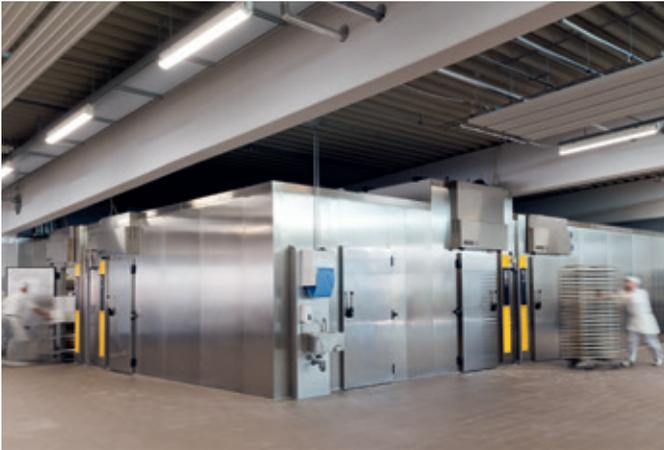
Главная установка представляет собой большой блок, состоящий из холодильных камер (слева), установки мгновенной заморозки (посередине) и большой установки глубокой заморозки (справа).
