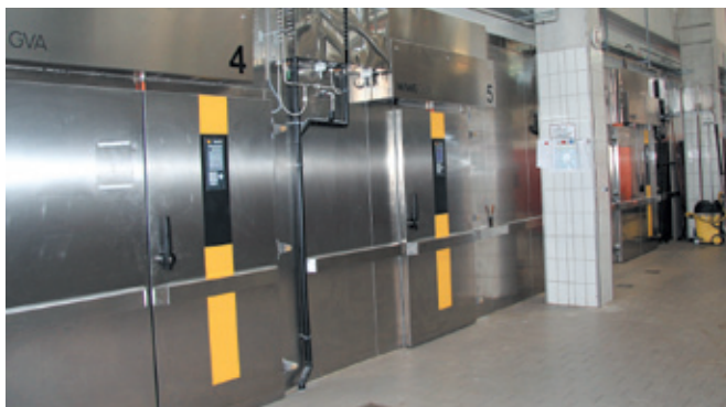
An die Produktionshalle angebaut befinden sich die Kälteflächen der Bäckerei.
