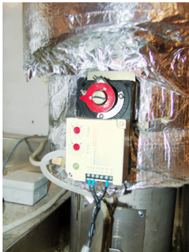
Детальное представление технического оборудования: сервопривод инновационного клапана динамической регулировки тяги.
