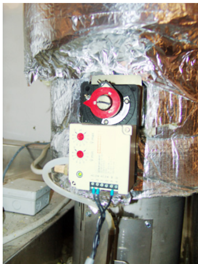
Un composant technique : l'actionneur du nouveau clapet régulateur de tirage dynamique.
