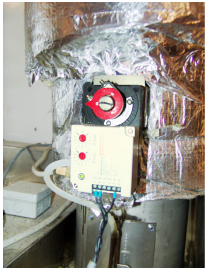
Technik im Detail: Stellantrieb der neuartigen dynamischen Zugregelklappe.
