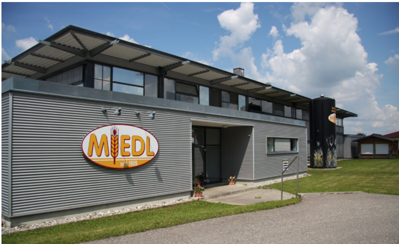
С 2001 года производство располагается в «Хандвэркерпарк» (Handwerkerpark) города Бад-Эндорф. Современная техника, традиционные рецепты и методы приготовления прекрасно друг друга дополняют.
