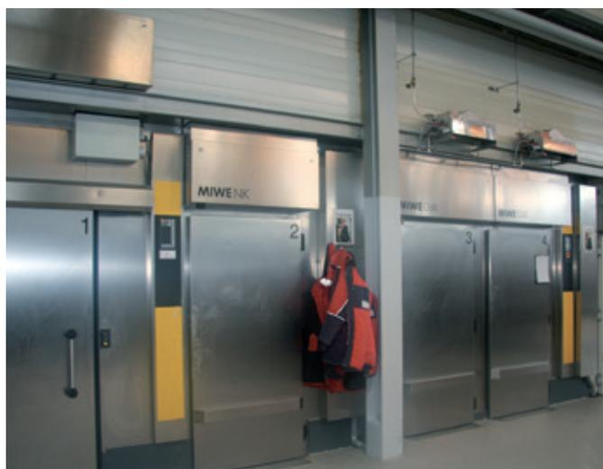
Les cellules de réfrigération avec surgélateur rapide, réfrigération normale et installations de fermentation entièrement automatiques, sont accolées latéralement au bâtiment qui accueille la production.
