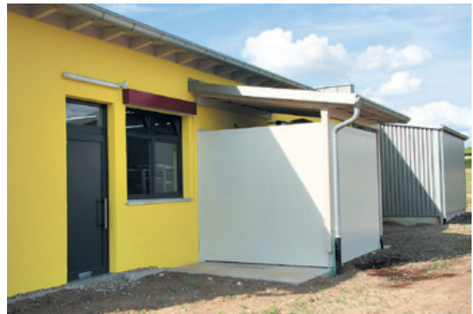
Außenansicht der TLK. Die Bodenplatte für die Platzierung des GVA ist bereits vorgesehen.
