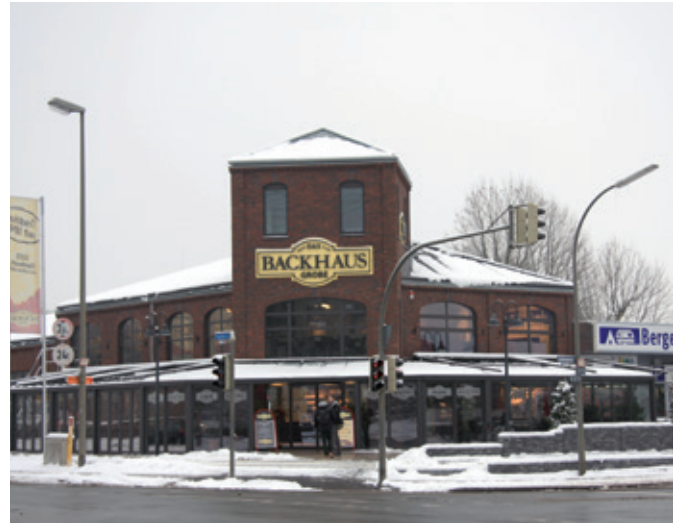
La façade caractéristique du bâtiment.
