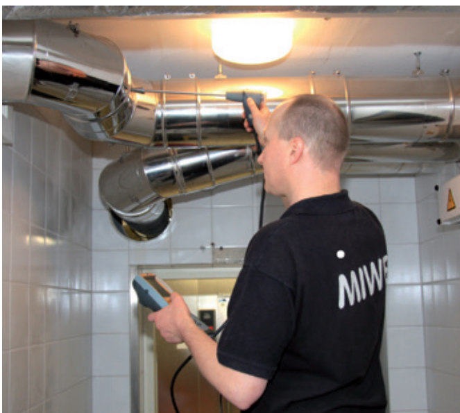
Сотрудники компании MIWE при выполнении измерения отработанных газов согласно DIN 8766.
