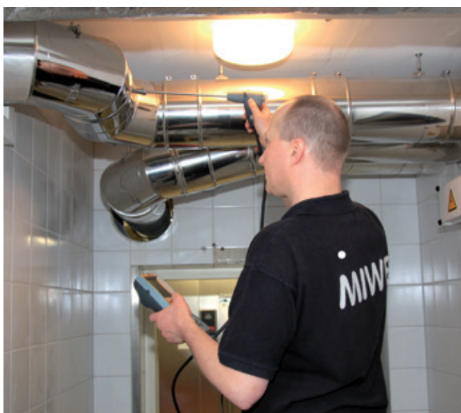
Un collaborateur MIWE effectue les mesures des gaz de fumée et les contrôles selon DIN 8766.
