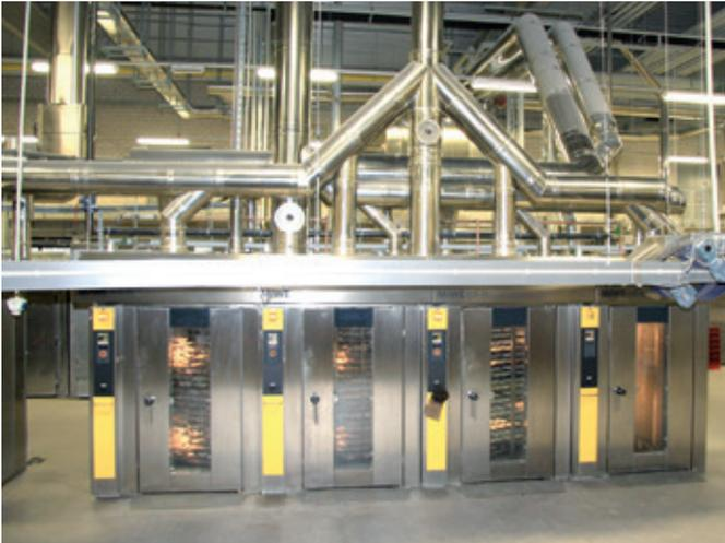
Aus Stikkenöfen MIWE roll-in e+ (im Bild) werden Rauchgas und Schwaden getrennt zu einer MIWE eco : nova geführt. Weitere Energie bekommt diese durch den Restschwaden von drei Thermoöl-Wagenöfen.
