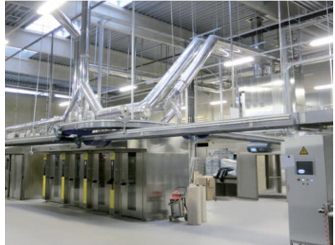
Der Energie-Überschuss der Stikkenöfen wird in Form von heißem Rauchgas und energiereichem Schwaden für die Wärmerückgewinnung zur Verfügung gestellt.
