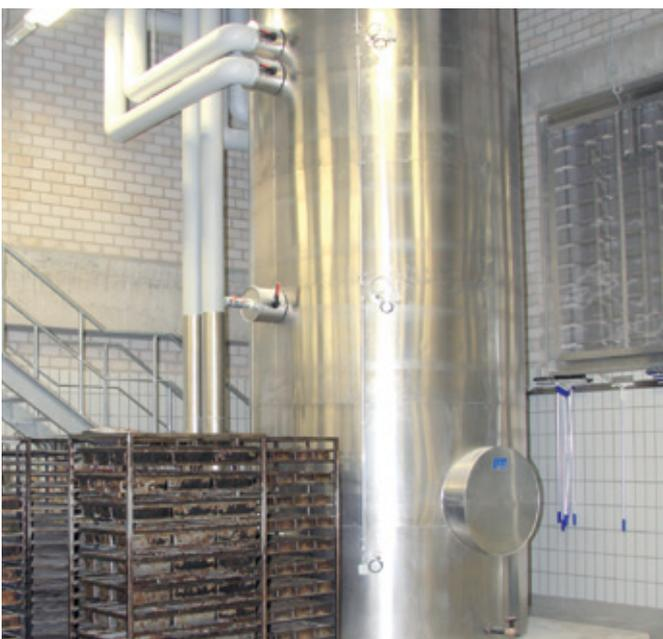
30.000 Liter fasst der Mehrschichten-Pufferspeicher, der die zurück gewonnene Energie ‚bunkert‘ und bei Bedarf bereitstellt.
