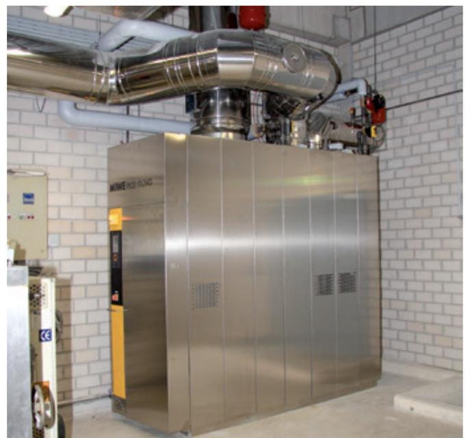
Eine MIWE eco : nova wird durch das Rauchgas der HKZ für die Thermoöl-Backöfen bedient. Sie ist direkt neben der Heizkesselzentrale platziert.
