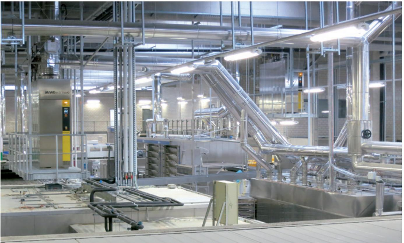
Die überschüssige Energie aus Stikken- und Wagenöfen wird in eine MIWE eco : nova geleitet, die über einer Kältezelle installiert ist. Dies spart lange Rohrleitungen und insbesondere auch Platz.
