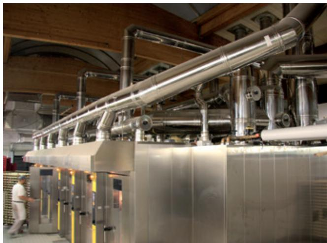
Дымовой газ и пар от стеллажных печей с одной стороны и от MIWE ideal с другой стороны направляется в систему рекуперации тепла MIWE eco:pova (на первом плане), от которой отходит всего лишь один дымоотвод с проходом через крышу.
