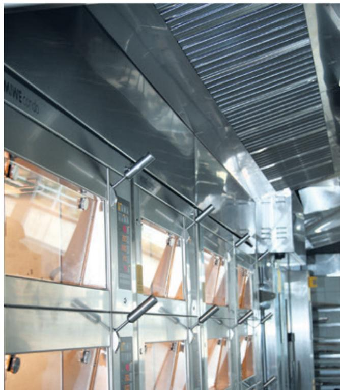
Создание благоприятного климата в учебных пекарнях обеспечивается мощной вытяжной системой, проведенной над хлебопекарными печами.
