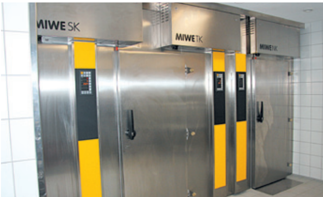
Kältetechnik gehört heute in die Bäckerei. Kühlzellen für Sahneprodukte (MIWE SK), Tiefkühlung (MIWE TK) und Normalkühlung (MIWE NK) stehen zur Verfügung.
