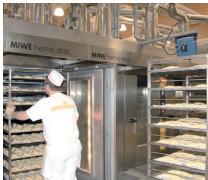
Travaux au niveau du MIWE thermo-static.
