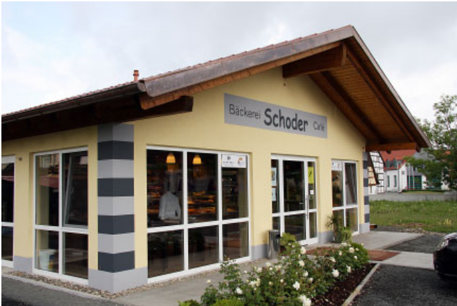
Für die neue Filiale in Untermerz bach hat Familie Schoder extra ein Gebäude errichtet
