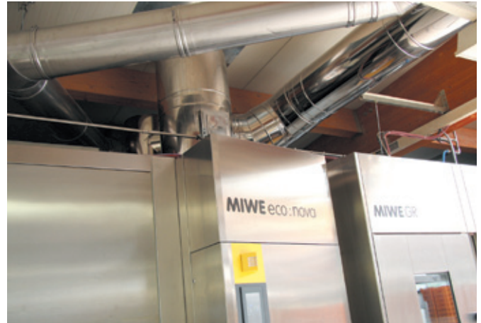
Detailansicht der eco.nova: Von den Backöfen kommt ein Rohr für Rauchgas und ein Rohr für Schwaden.
