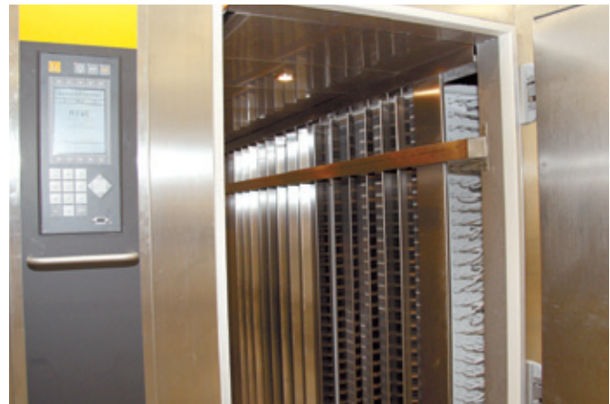
Einer der Schockfroster hat seine Verdampfer an der Seite (Bild). Der andere hat sie oben, um später eine Durchschiebeanlage einbauen zu können.
