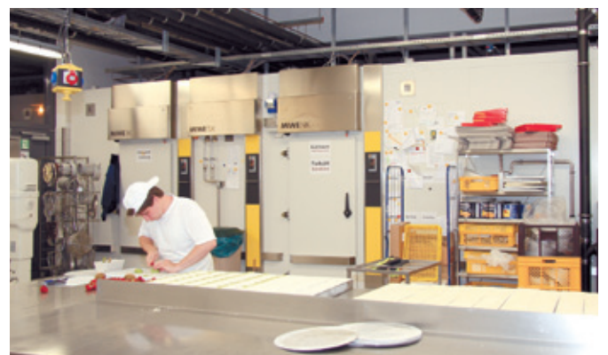
Blick in die Konditorei. Von hier aus können die Kältezellen direkt begangen werden.
