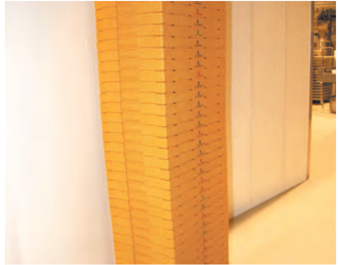
Die gute Isolierung der Dielen ermöglicht es, dass die Teiglinge ohne Fahrzeugkühlung in die Filialen gebracht werden können.
